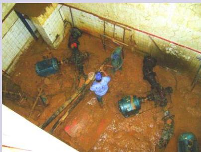
•04 conjuntos motobomba horizontales, 200 CV, operando en paralelo, succionando en pozos y trasvasando hasta la ETA. Q=220 l/s;
